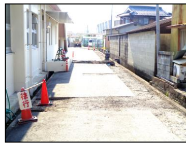
北面通路の工事
