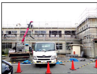
足場設置作業
