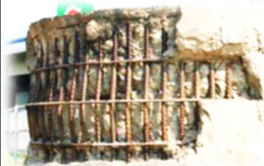
震災で折れた橋脚 (国道2号線沿い)
