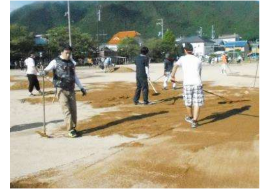
土入れと整地
