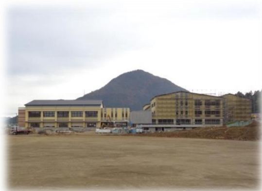
建築中の新山南中学校校舎
