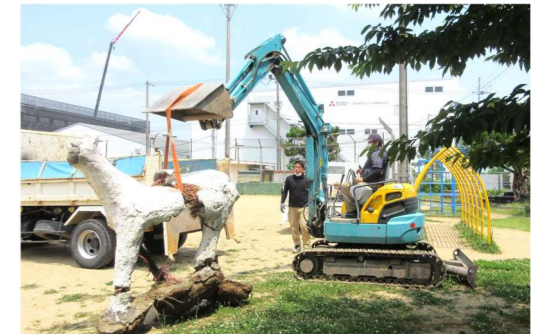
重機での撤去作業
